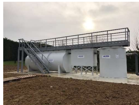
Traitement des eaux pluviales
