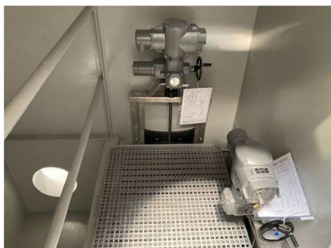
Isolement et sécurisation des réseaux
