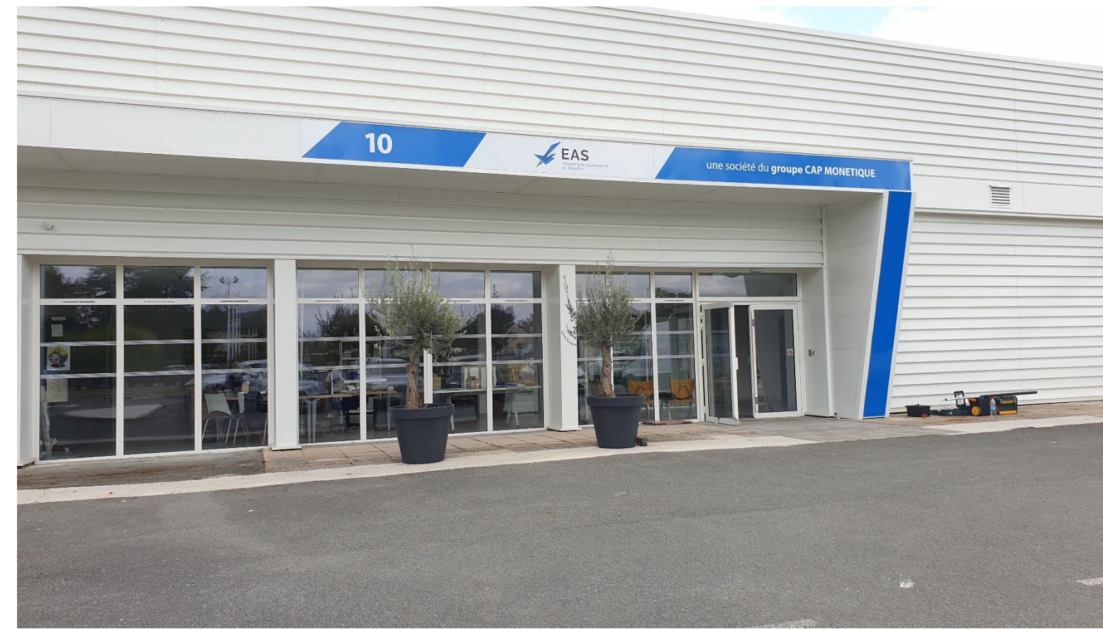
Batiment de production: 8-10 Rue François Mitterrand
